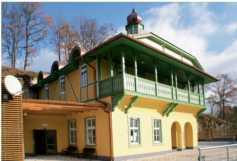
Provozní budova po rekonstrukci
