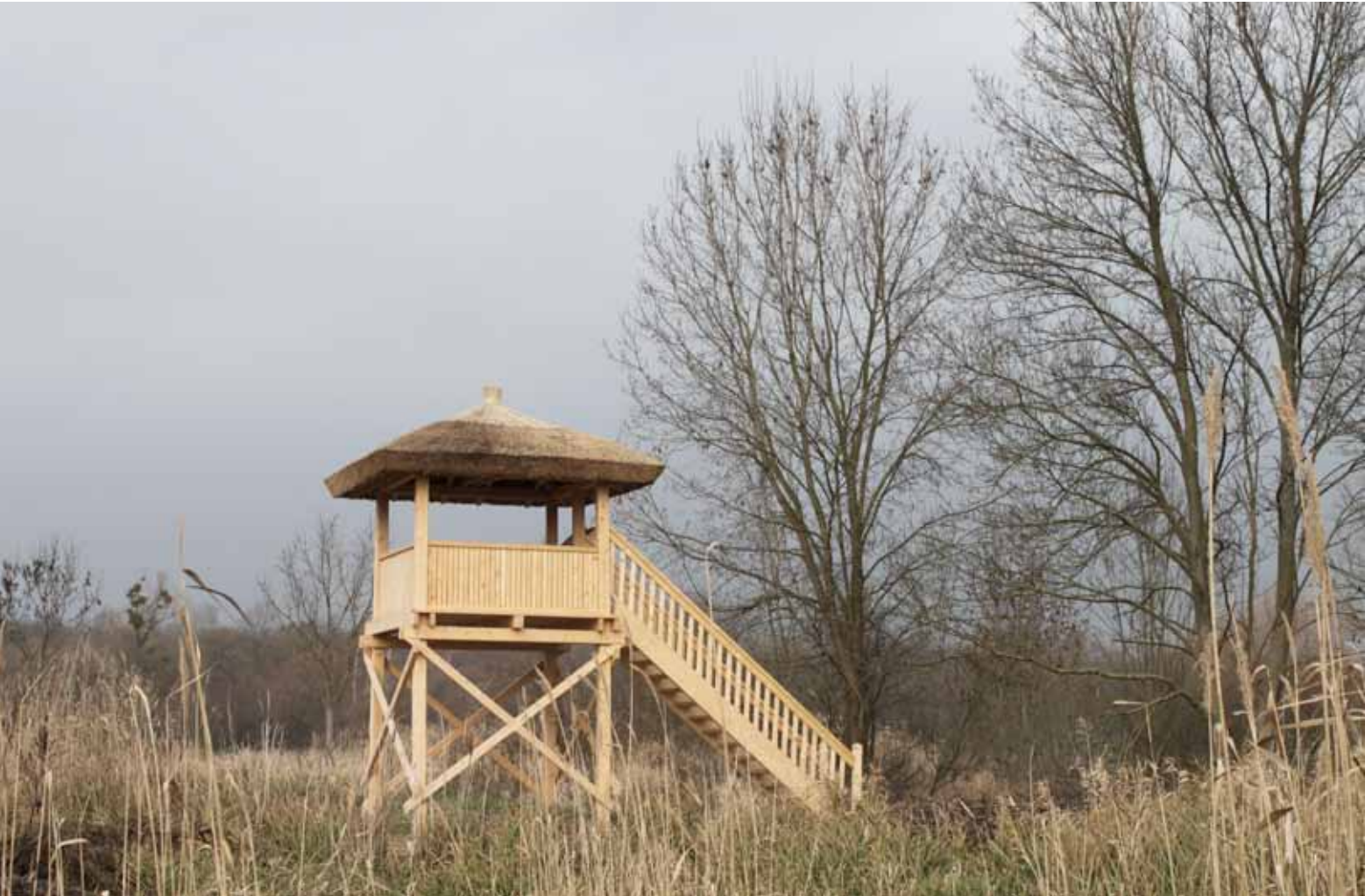
Ptačí pozorovatelna se střechou z rákosu v NPP Pastvisko u Lednice realizovaná v roce 2013. Foto: V. Sajfrt
