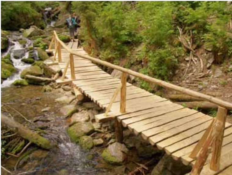
Lávka na naučné stezce Bílá Opava v NPR Praděd v CHKO Jeseníky obnovená v r. 2014. Foto: M. Ulrych
