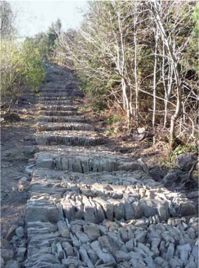
Detail štětovaného chodníku na Lysou horu v CHKO Beskydy před dokončením. Základ bude klínován drobnějším kamenivem, na kterém bude dále rozprostřena a udusána vrstva zeminy. Foto: J. Müller
