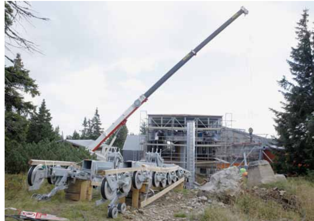
Třicetitunový jeřáb zdvihá hlavu první podpěry nad stanicí Růžová hora 5. září 2013. Podpěra č. 1 horního úseku je jediná trubkové konstrukce. Výš už musely být instalovány podpěry příhradové konstrukce, které tolik nenarušují krajinný ráz. Foto: Jiří Bašta
