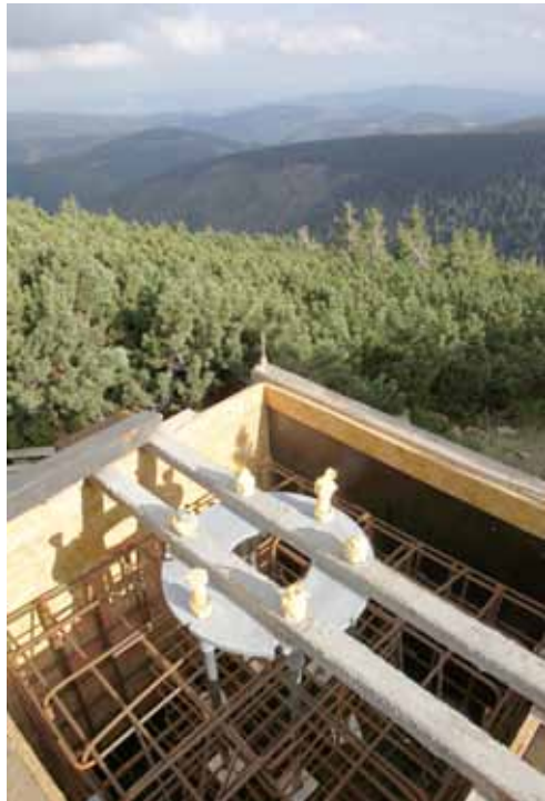
Armatura patky sloupu v bednění na úbočí Sněžky 5. září 2013. Foto: Jiří Bašta
