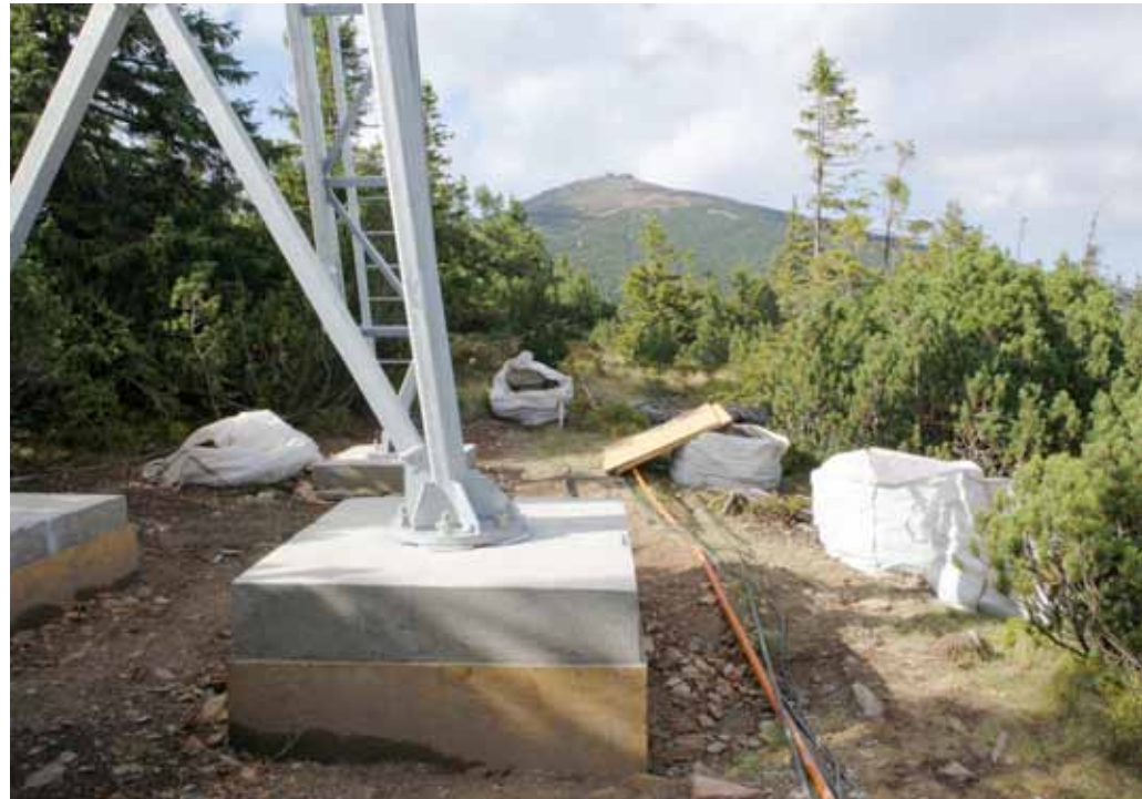
Podpěry horního úseku jsou atypické trojnožky příhradové konstrukce, napodobující původní; využívají výkopy po patkách staré lanovky. I tak měly helikoptéry co odnášet. Foto: Jiří Bašta
