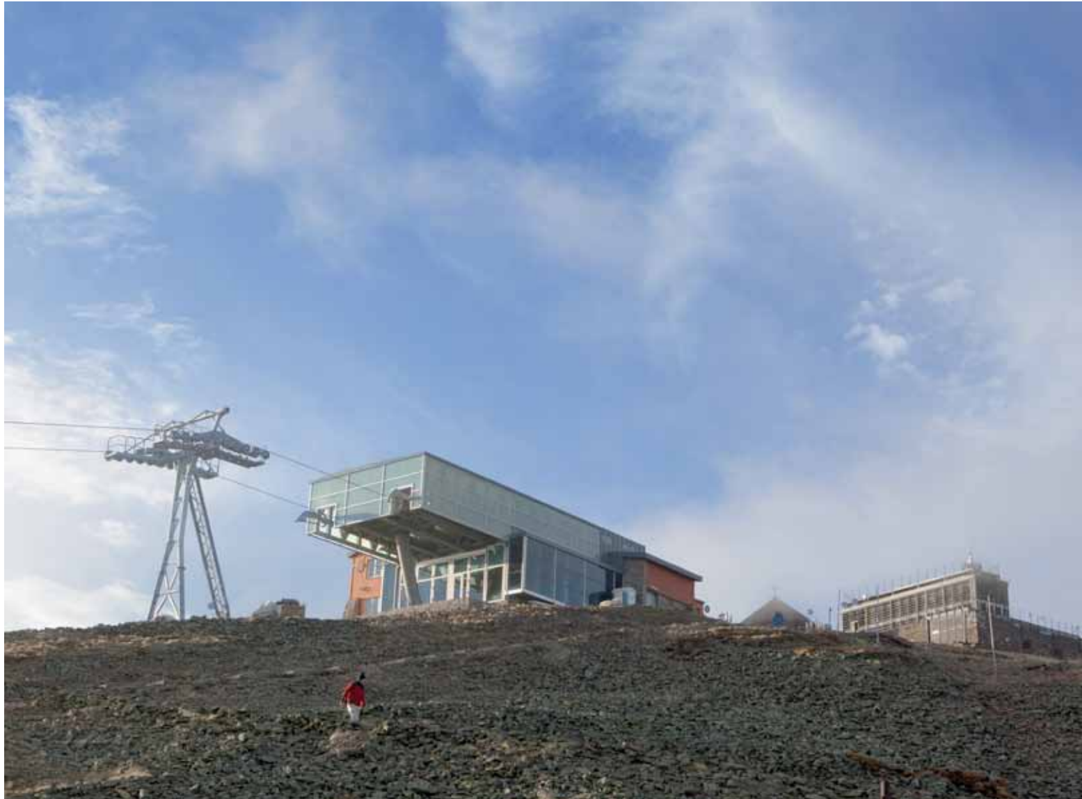
Střecha kaple sv. Vavřince se při příchodu od Růžové hory vynořuje v úběžníku dvou různě velkých, bohatě prosklených hranolů. Rozdíl měřítka je neúprosný. Při rekonstrukci stanice lanovky bylo využito maximum dochovaných konstrukcí. Přibyl nápadný kvádr kryjící technologii lanovky, dříve částečně ponechanou napospas živlům (19. října 2013). Foto: Jiří Bašta
