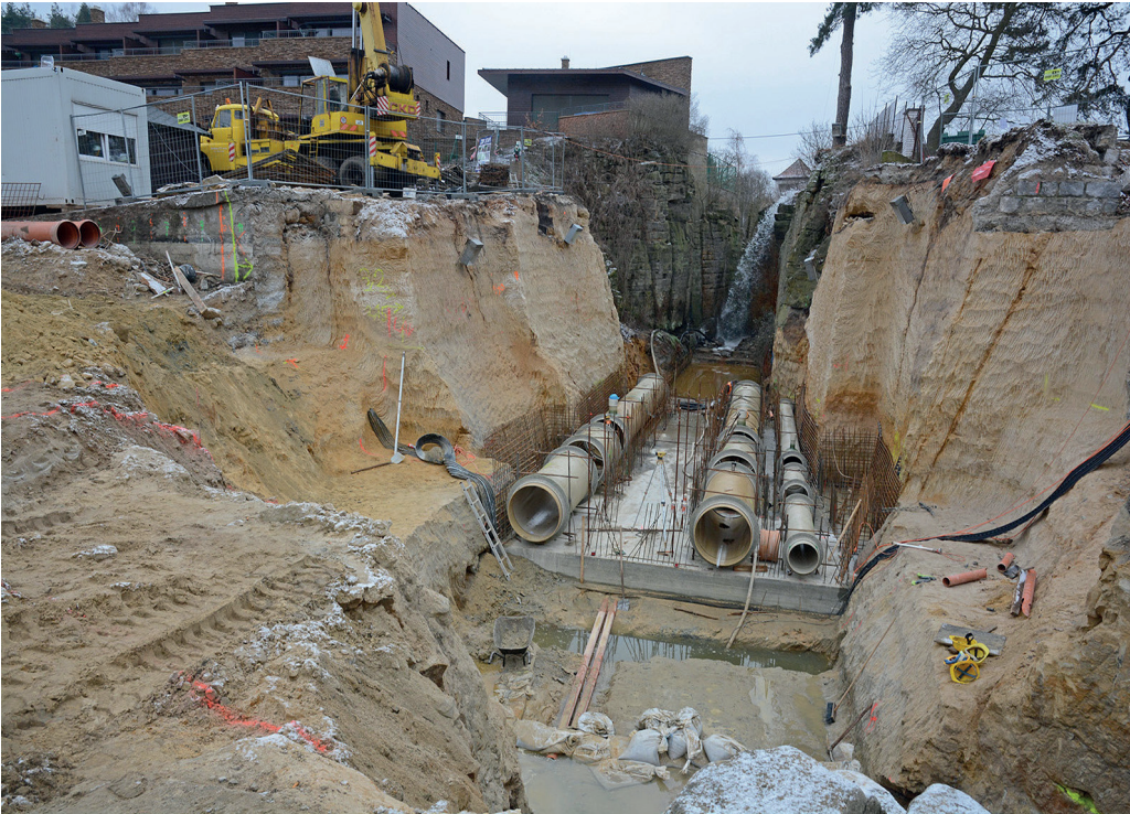
Staveniště při rekonstrukci výpustního zařízení Máchova jezera ze dne 24. 1. 2015: pohled z provizorní bariéry do výpustní strouhy (tedy po proudu Robečského potoka). Foto Jiří Adamovič.
