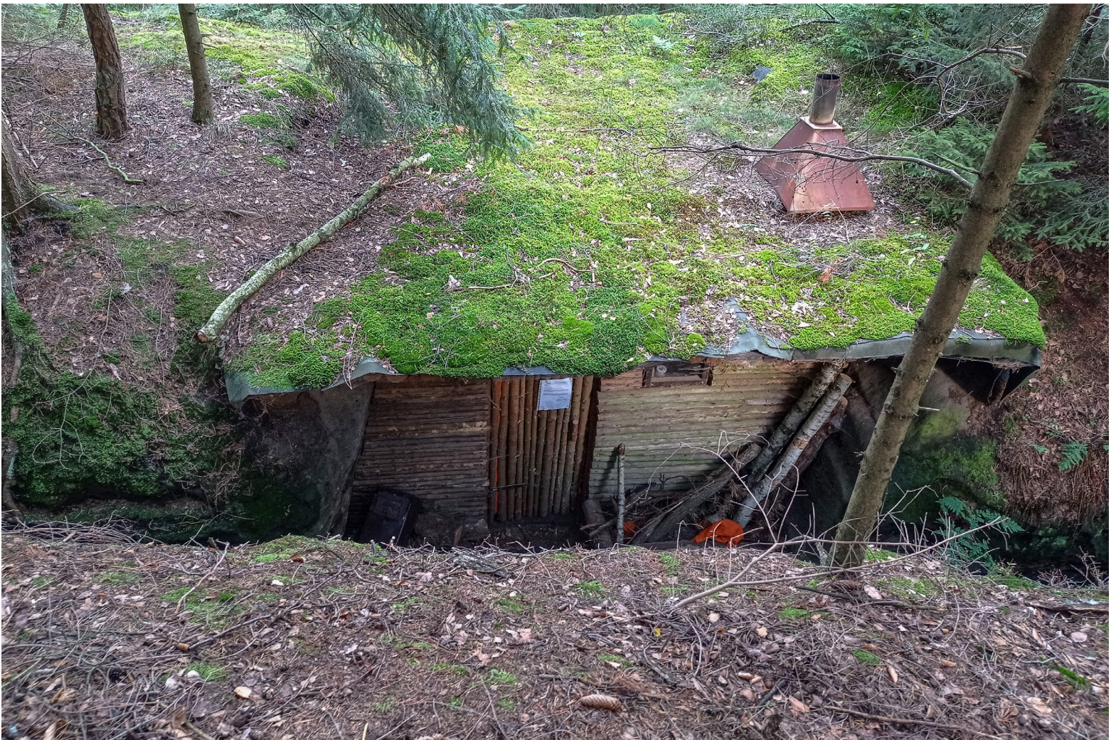
Obr. 1: Frontenac byl podle stavebního úřadu stavbou, na pozemku AOPK ČR, v PR Kokořínský důl. Byl zrušen v roce 2022. Foto Ladislav Pořízek
