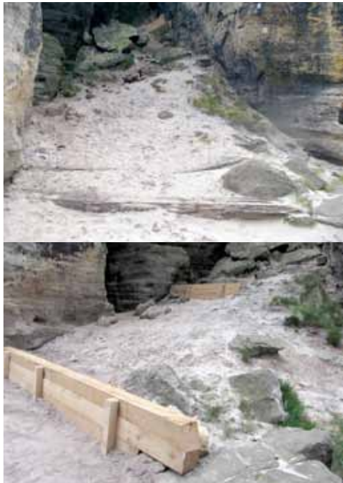
Původní, již nefunkční protierozní opatření, byla nahrazena novými přehrázkami. Foto: Veronika Bohuňková, 2012, 2014
