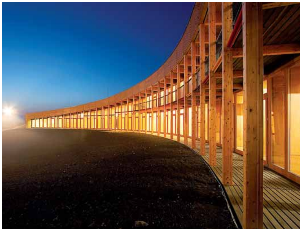
Budoucí Dům přírody Litovelského Pomoraví může vzniknout z centra Slučákov. Jde o unikátní nízkoenergetickou stavbu, konstruovanou jako obydlí terénní vlna plynule zapadající do okolního terénu. Foto A. Lhotáková
