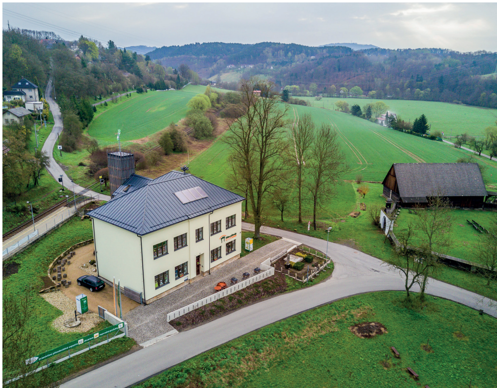
Bývalá škola v Dolánkách u Turnova byla přestavěna na Dům přírody Českého ráje dle projektu Projektového ateliéru David z Liberce. V podkroví je umístěna interaktivní expozice. Foto Petr Jan Juračka
