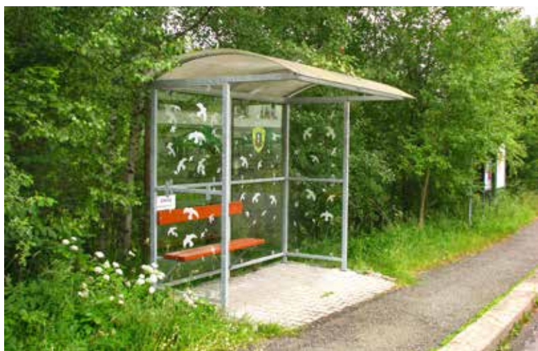
Nebezpečná zastávka v Mnichovicích, umístěná v zeleni, do jejíchž průhledných skleněných ploch naráželi ptáci, byla zabezpečena samolepkami. Foto Petr Dobrý
