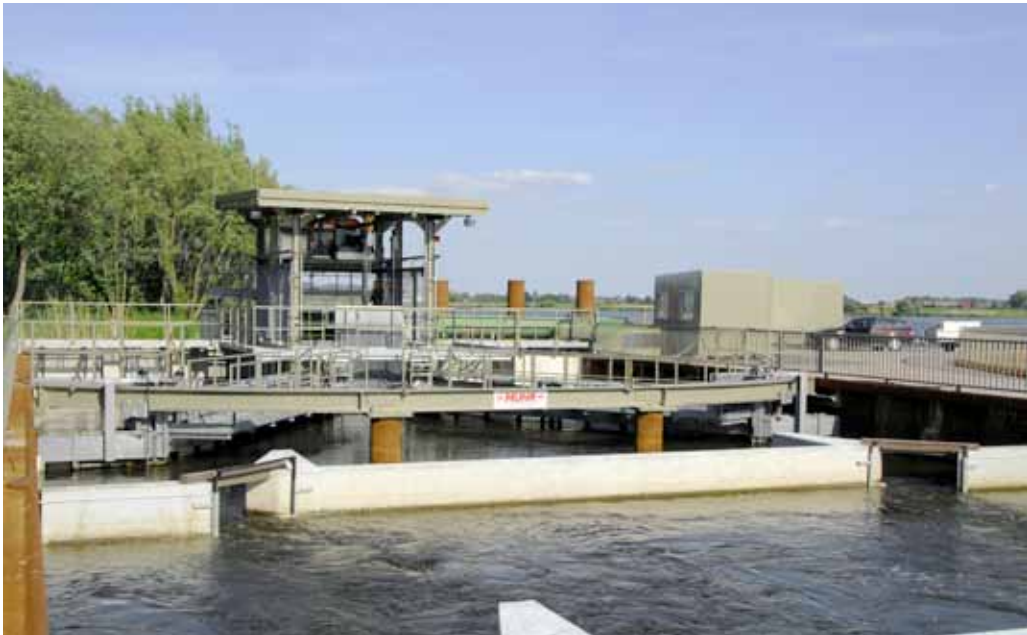
Monitorovací zařízení pro odlov labské ichtyofauny migrující novým dvoušterbinovým přechodem na vodním díle Geesthacht. Foto: Beate Adam
