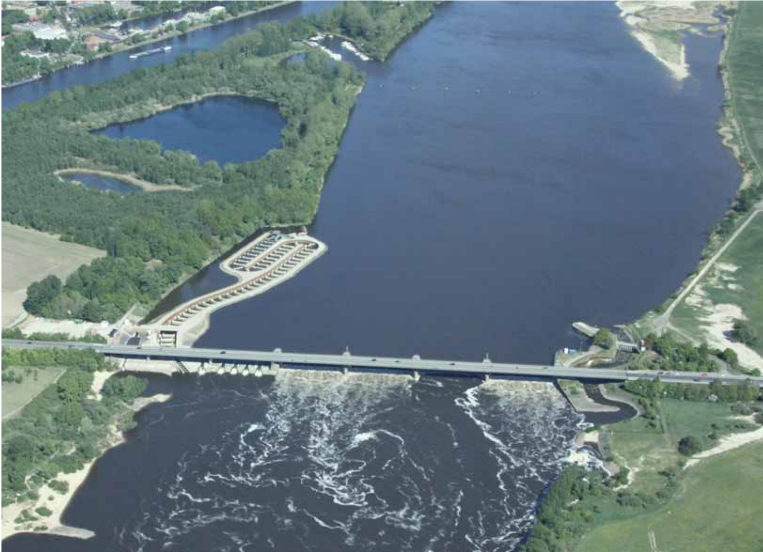
Vodní dílo Geesthacht na Labi před Hamburkem. Vlevo je nový dvouštěrbinový technický přechod, vpravo starší obtok (bypas) pro migrace labské ichtyofauny. Foto: Beate Adam
