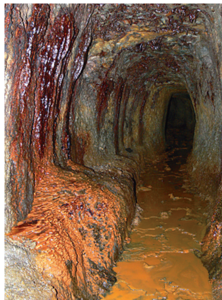
Železité průsaky v interiéru ručně tesané štolky na Kraslicku
