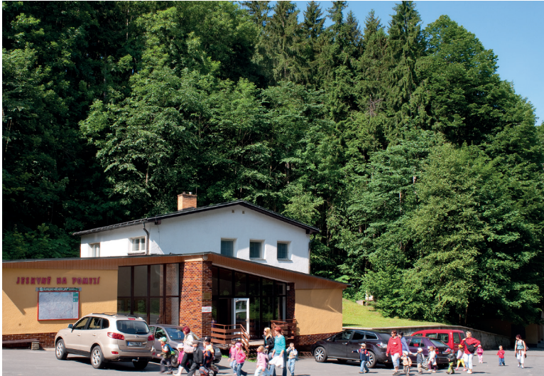
Provozní budova jeskyně Na Pomezí. Foto Petr Zajíček, SJČR
