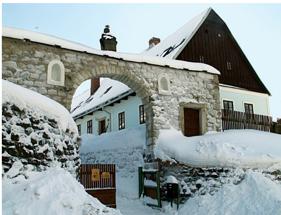
Budova Správy CHKO Broumovsko se nachází v památkově chráněném Vlachově statku v Polici nad Metují. Je ukázkou typické místní architektury.
