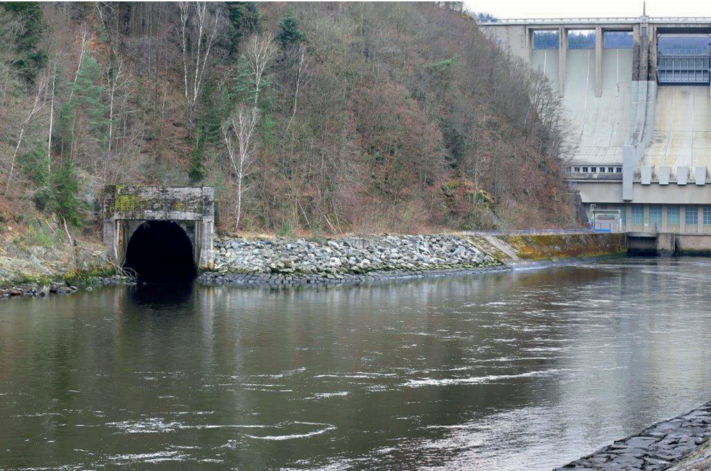
Obr. 1 Vstupní portál obtokového kanálu vodního díla Slapy. Foto M. Anděra
