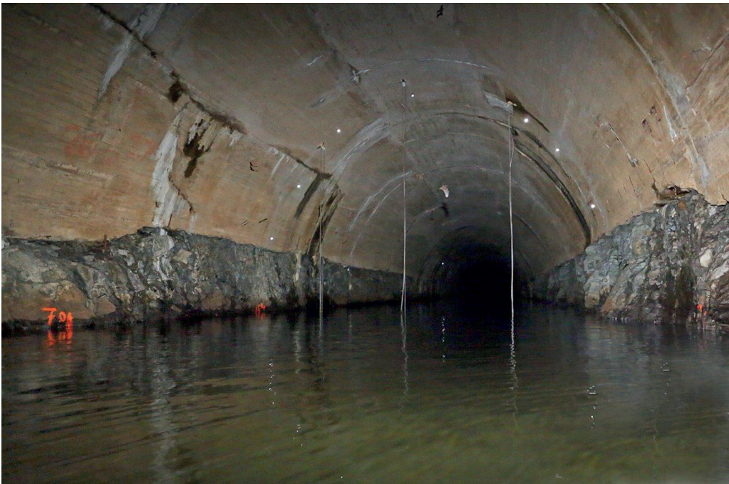
Obr. 2 Obtokový kanál vodního díla Slapy je zatopený a přístupný pouze lodí. Foto M. Anděra
