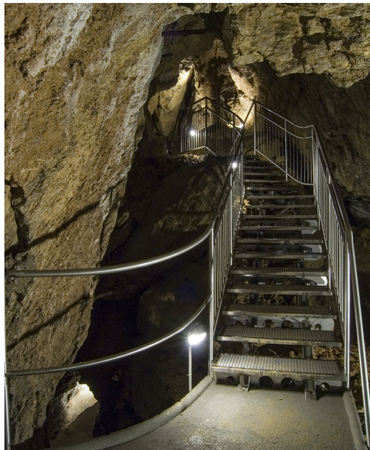
Obr. 4: Gallašův dóm po rekonstrukci. Odstraněny horninové zakládky, zamaskováno odsávací potrubí, betonové schody nahrazeny nerezovým schodištěm. Foto Petr Zajíček
