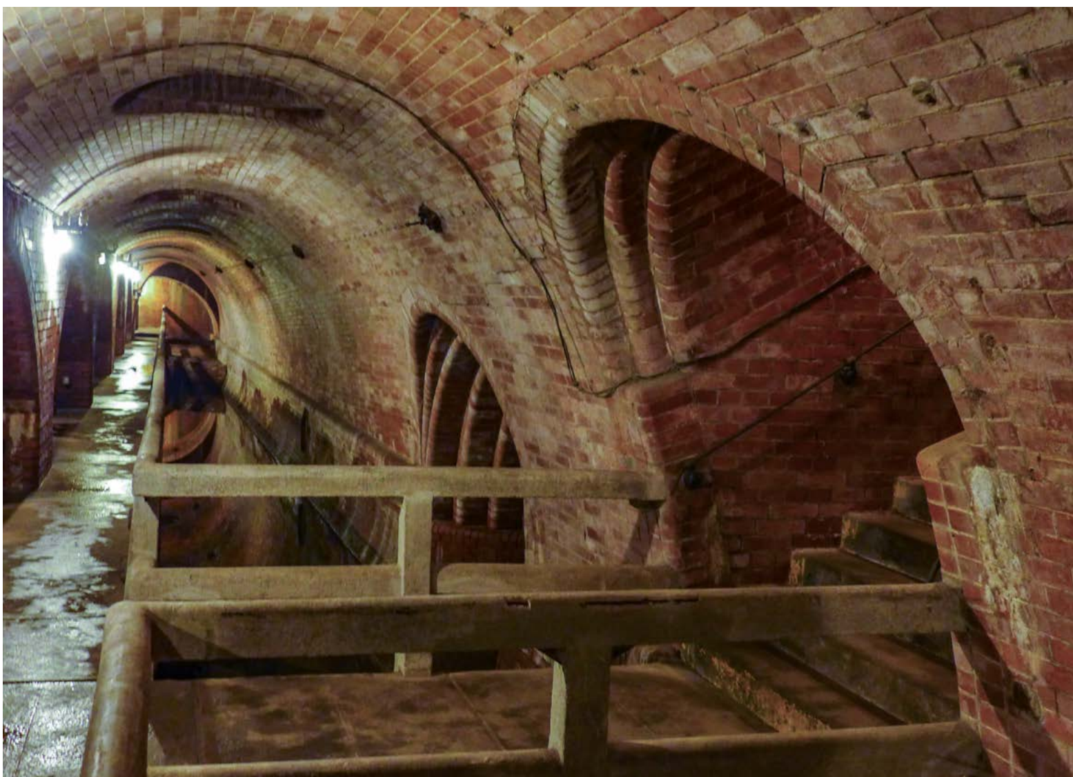
Obr. 1: Přítoková galerie podzemních usazovacích nádrží. Vpravo za přístupovým schodištěm jeden ze dvou přítoků od lapače písku. Vlevo portály usazovacích nádrží. Foto Tomáš Just
