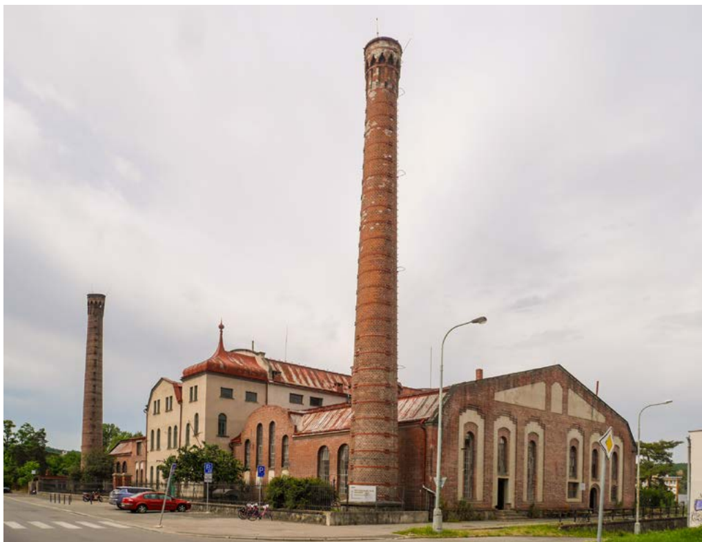
Obr. 2: Národní kulturní památka Stará kanalizační čistírna v Praze-Bubenci; provozní budova v Papírenské ulici v roce 2025. V popředí ventilační komín, vzadu komín kouřový, obsluhující kotelnu parních strojů. Foto Tomáš Just
