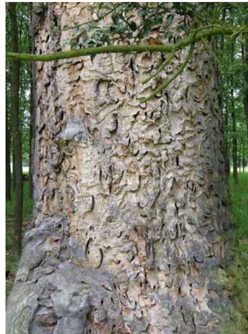
Výletové otvory tesaříka obrovského. Foto: Jaroslav Šreiber
