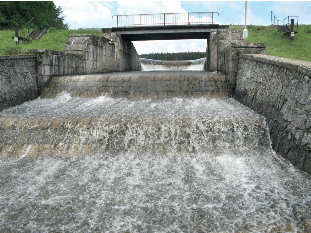
Obrázek 7 Přetok povodňovým přelivem typu „kachní zobák“ na vodním díle Láz dne 25. 5. 2018, ve 14:22, tedy už za vrcholem povodně. Foto Karel Žák
