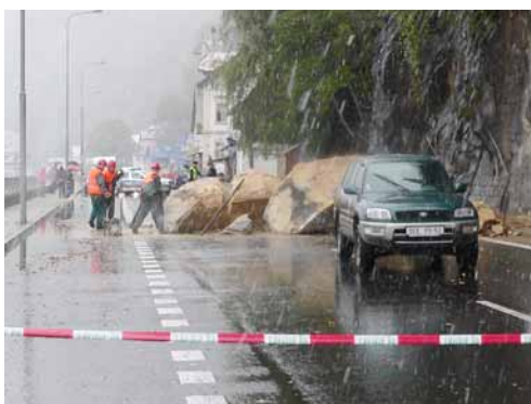
Obr. 3 Odklizení skalního bloku zříceného v roce 2009. Foto: Zuzana Vařilová
