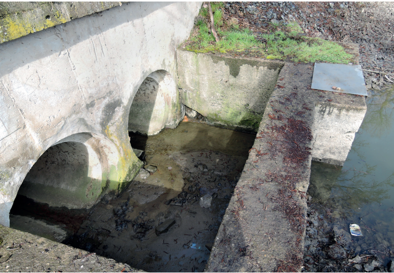
Silnice po hrázích rybníků jsou problém v krajině. Výpustní zařízení či sružený objekt bývají pro vydry neprůchozí a řešení je složité. Většinou lze najít u bezpečnostního přepadu místo pro schůdky či rampu, po které vydry bezpečně přejdou z toku na rybník. Foto Lukáš Poledník
