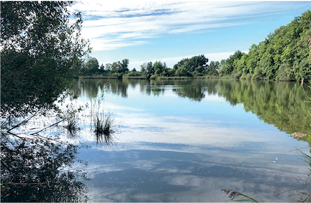
Obr. 4 Rybník Nový u Golčova Jeníkova (katastr obce Podmoky), pohled z odběrového místa u pravé strany hráze, současný stav. Foto Pavel Punčochář
