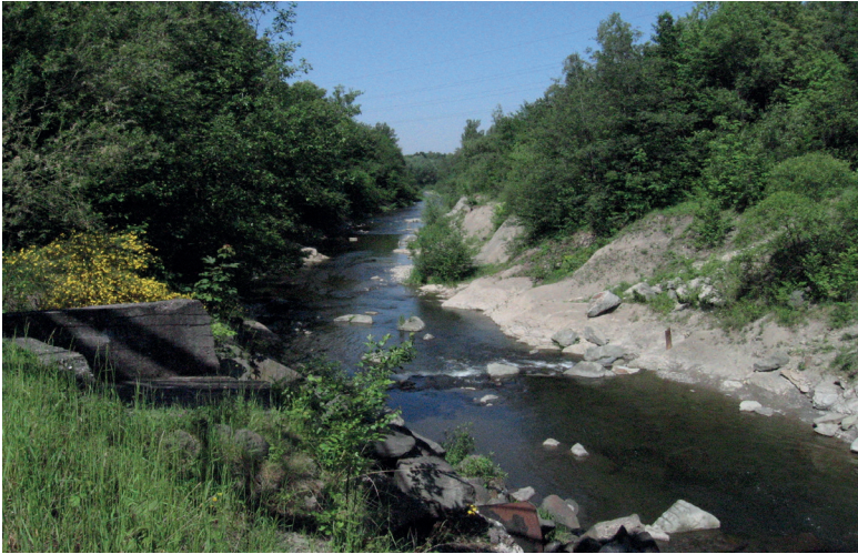
Obr. 5 „Přirozeně“ zahluobené koryto Morávky v důsledku antropogenních zásahů do morfologie toku; PP Profil Morávky. Foto Hana Mlejnková
