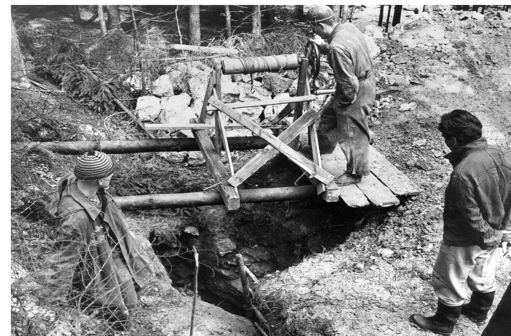
Průzkumná sonda hloubená v místě výrazné geofyzikální anomálie potvrdila nové jeskynní prostory. Foto Archiv SJ ČR
