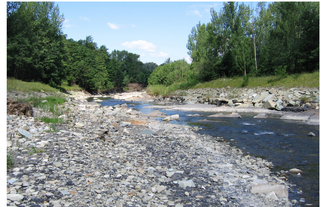
Hlubkovou erozí postižené lokální rozšíření koryta na řece Morávce po povodni v roce 2010. Foto Václav Škarpich
