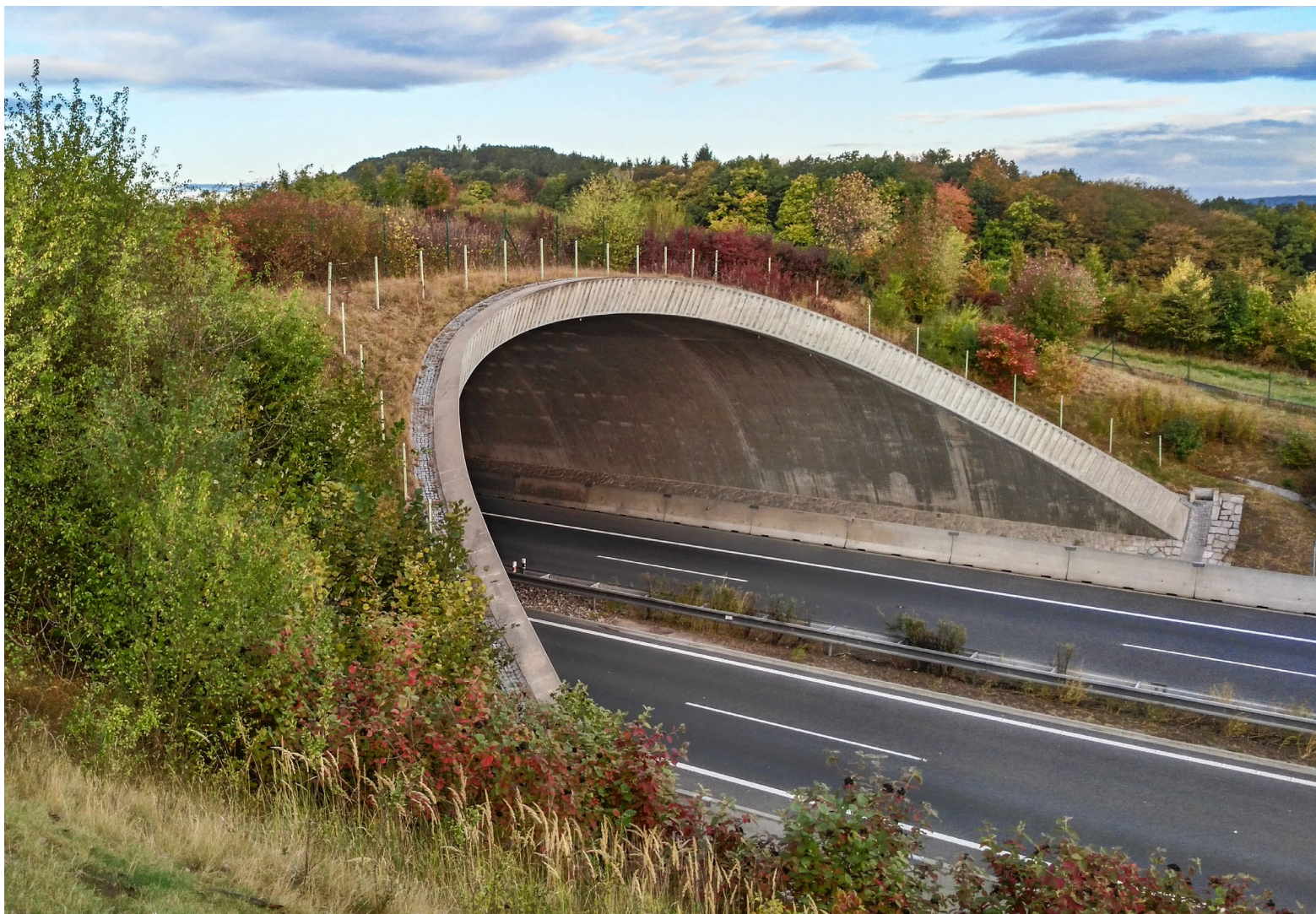
Obr. 1: Ekodukt na dálnici D11 v lokalitě Žehuň. Foto Martin Strnad
