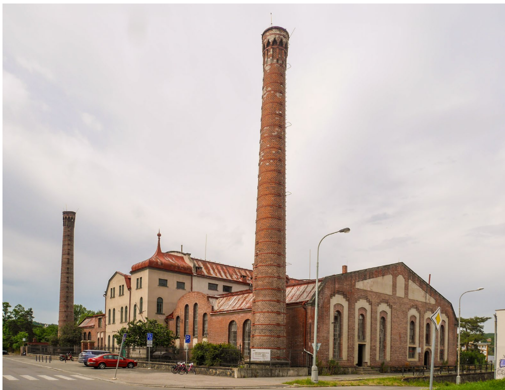
Obr. 2: Národní kulturní památka Stará kanalizační čistírna v Praze-Bubenci; provozní budova v Papírenské ulici v roce 2025. V popředí ventilační komín, vzadu komín kouřový, obsluhující kotelnu parních strojů. Foto Tomáš Just
