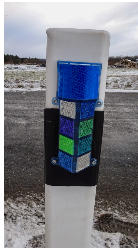
Obr. 3: Opticko-pachový odpuzovač Hagopur Kombiset. Foto Jitka Uhlíková
