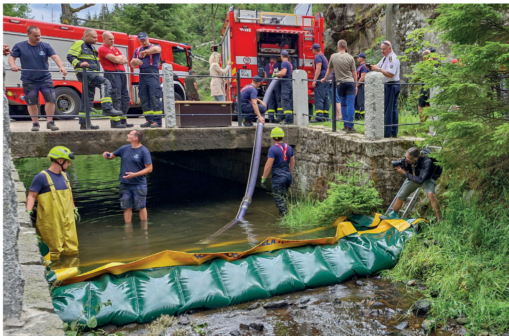
Spolupráce s hasiči patří ke klíčovým činnostem při prevenci rozsáhlých požárů. V krajině přirozeně chudé na vodní zdroje je často nutné přikročit ke kreativním řešením. Na snímku na míru vyvinutá vzdouvací přepážka pro malé vodní toky. Foto Tomáš Salov
