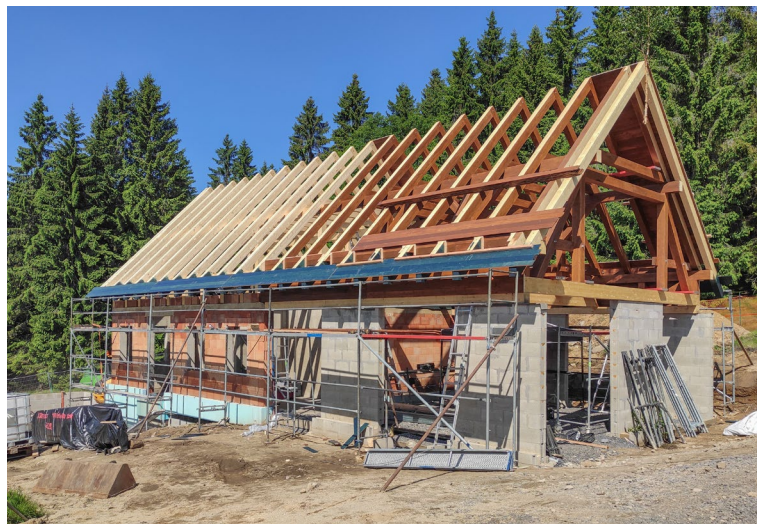
Obr. 8 Stavba Informačního střediska CHKO Jizerské hory – Mariánskohorské Boudy je spolufinancována z Národního plánu obnovy a pro veřejnost se otevře na jaře 2026. Foto Daniel Kopecký
