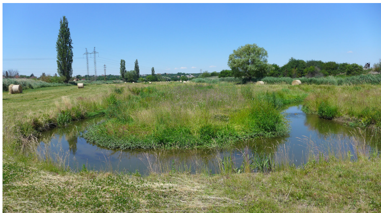
Revitalizace Říčanky v Praze mezi Dubčí a Běchovicemi (dříve tu bylo přímé, hluboko zaříznuté koryto „melioračního“ typu). Nové koryto je morfologicky dobře tvarováno, je přirozeně málo kapacitní, hladiny vody nejsou nadměrně zaklesnuté proti okolnímu terénu. Foto Tomáš Just
