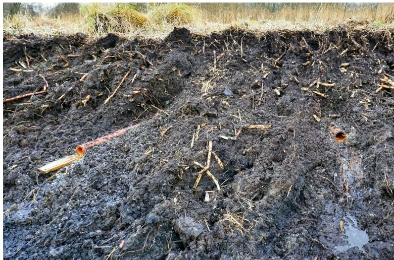
Vystupující drenáže z půdního profilu – někdy byly pokládány na prkna a do šterko-písku. Foto Vojtěch Šťastný
