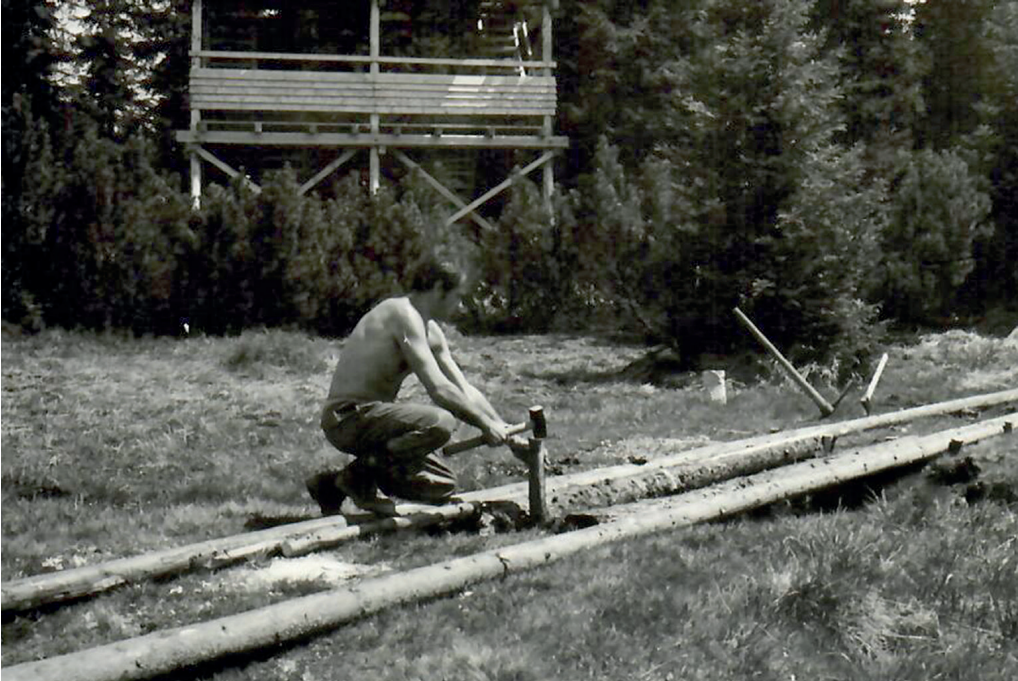
Rok 1974 – budování první poválky a vyhlídkové věže na Jezerní slati. Foto Š. Labaj
