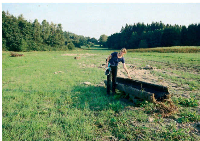
Pod protrženým rybníkem Melínem, kterým začala zkáza blatenské rybníční soustavy, vede směrem k Metelskému rybníku rovněž upravené, ale velmi malé a mělké koryto potoka. Průlomová vlna z rybníka se rozlila do ploché nivy. Malé koryto i travnatý povrch nivy odolaly účinkům proudění. Na obrázku část dřevěného výpustního potrubí rybníka, jak je vlna upustila uprostřed nivy
