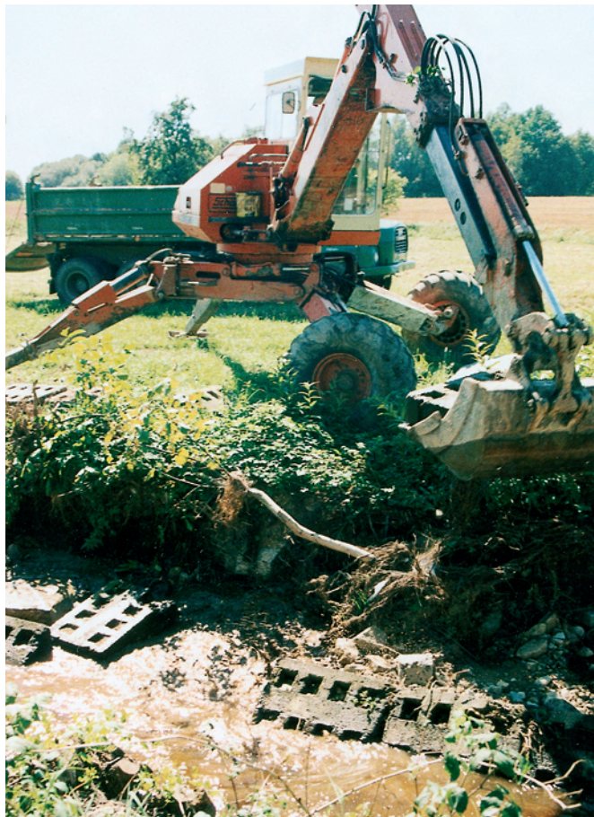
Hvožd'anský potok. Popovodňové odstranění nevhodných polovegetačních tvárníc a jejich nahrazení kamenným záhozem je prvním krokem k revitalizaci potoka. Neřeší sice nadměrnou hloubku a malou půdorysnou členitost upravené trati, ale aspoň vrací členitost příčnému i podélnému profilu toku Všechny snímky T. Just
