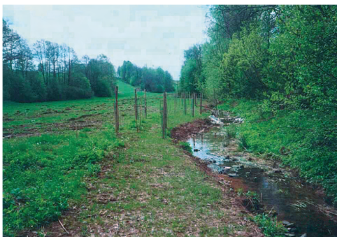
Náprava nevyhovujících poměrů – revitalizační úprava Mezilabského potoka (okres Trutnov) v roce 2001, vytvoření podmínek pro návrat přirozených společenstev podhorské nivy. Provedena úprava profilu a spádu, doplněno výsadbou do parametru lokálního biokoridoru
