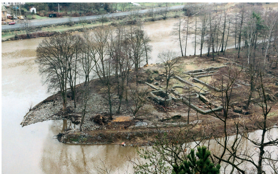
Ostrov sv. Kiliána u Davle. Proud byl tak silný, že poškodil masivní říční navigaci na špičce ostrova. Říční ostrovy na Vltavě, které dříve nebyly chráněny kamennými hrázemi, při povodních často zanikaly nebo měnily tvar. Všimněte si, že areál románského kláštera je z povodňových důvodů postaven na uměle vyvýšené plošině
