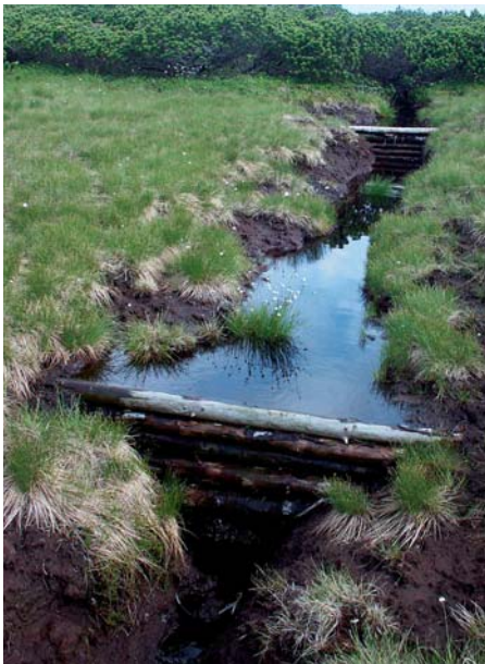
Přehrádky na odvodňovacím kanále na Jeřábí louce
