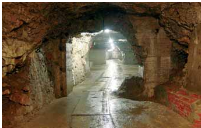
Chodba od vchodu č. 1
