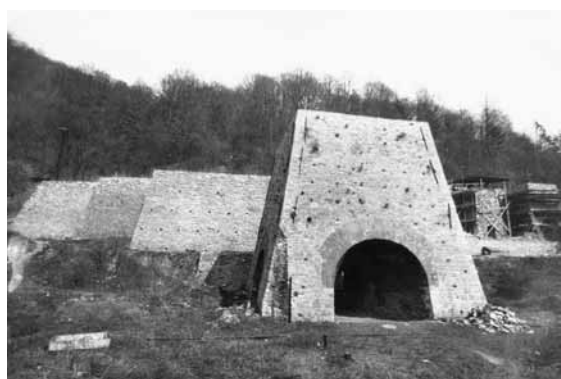
Vysoká dřevouhelná pec v Josefově během stavebních úprav
