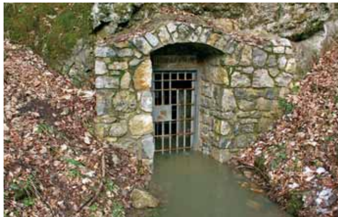
Uzávěra jeskyně Ochozské umožňuje vlet netopýrů, ale i výtok vody z jeskyně Foto Ivan Balák
