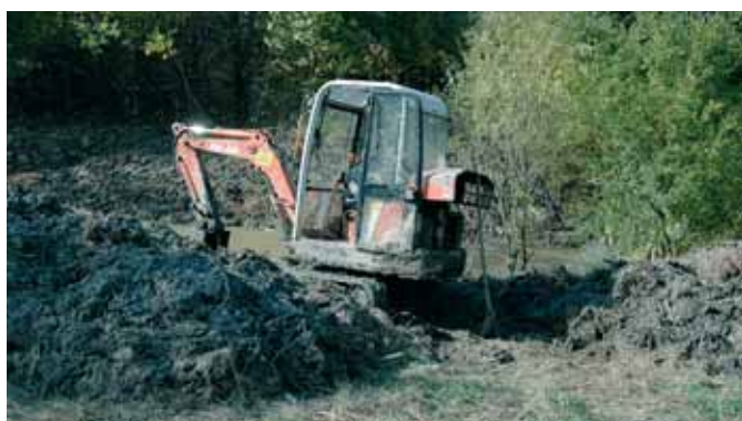
Rudické jezírko Velká Halda, provádění zásahu - úpravy jezírka Velká Halda jsou rozděleny na tři roky, základem prací je bagrování a úprava svahů Foto Roman Rozínek
