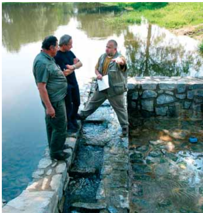
Nový bezpečnostní přeliv nádrže Chocholouš. K vnitřní stěně je přisazen rybí přechod pro malé druhy ryb, kterým procházejí běžné odtoky z nádrže
