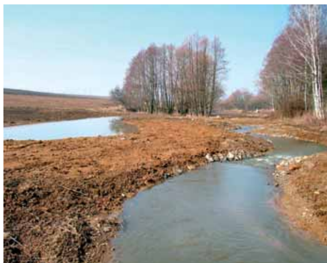
Pohled na nivu Boreckého potoka při dokončování revitalizace. Zde je zachycena právě vzorová modelace nového koryta potoka s tůněmi v obloucích a s kamenitým brodem v přechodu mezi oblouky
