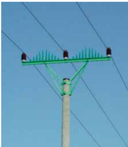
Sloupy elektrického vedení 22 a 35 kV s rovinnou konzolou představují velké nebezpečí pro dravé ptáky včetně sokola stěhovavého a raroha velkého. Instalace plastových hřebenu toto nebezpečí výrazně snižuje, neboť neumožňuje ptákům dosednout na konzolu mezi izolátory. Vážnou nevýhodou je však nízká životnost materiálu, která způsobuje časté odpadávání zábran
