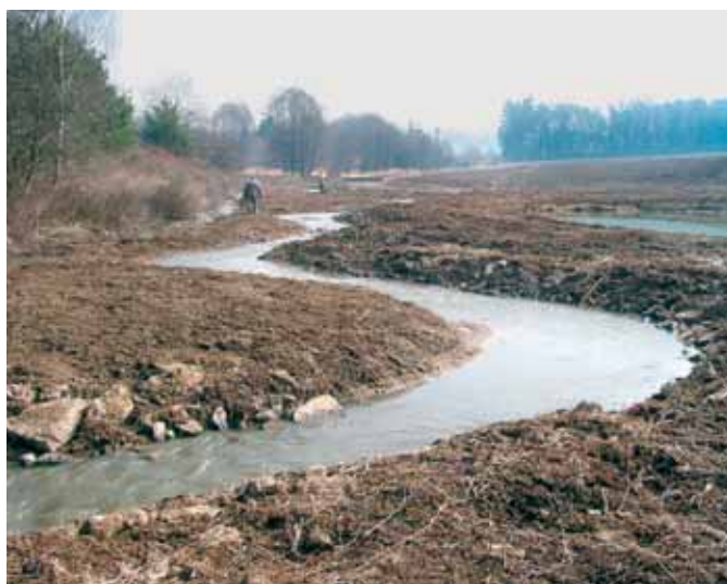
Revitalizace Boreckého potoka u Vlašimi: Nové, přírodě blízké koryto potoka v přeformátované nivě při dokončování stavby, na jaře 2005
