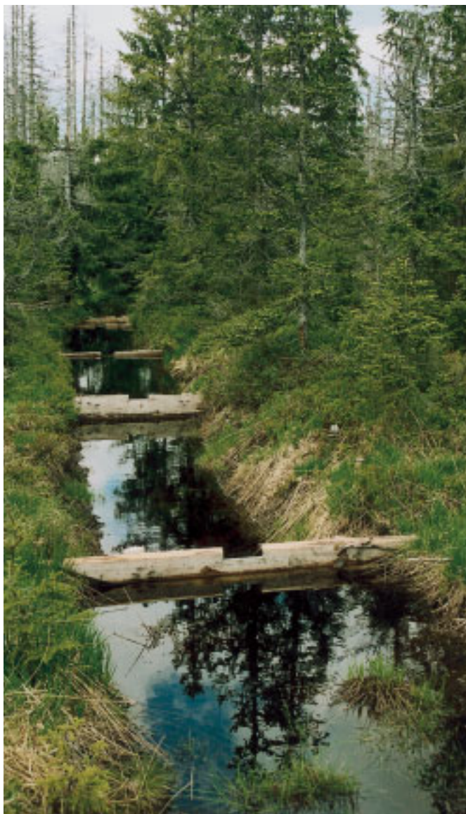
Obr. 1 – Kaskády hrází blokujících uměle prohloubenou meliorační rýhu
