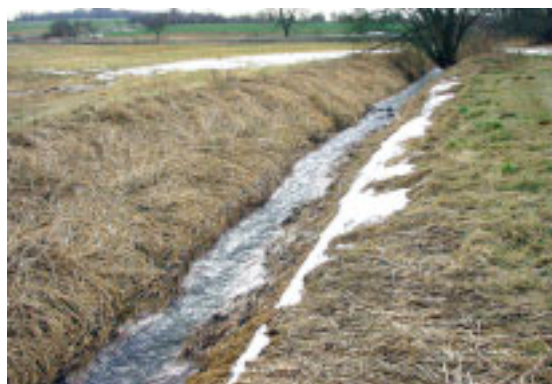
Technicky upravené koryto Brodce – snímek z dosud nerevitalizovaného úseku ←
