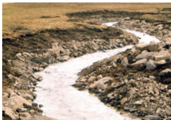
→ Revitalizační koryto v průběhu výstavby (zima 2002 – 2003)
