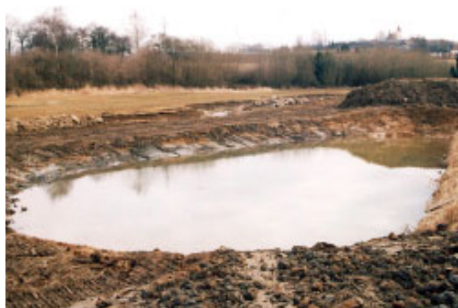
Hloubení jedné z tůní, založených v trase zrušeného upraveného koryta
