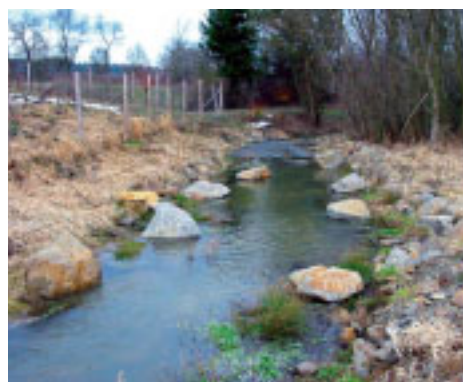
→ Úsek nového koryta pod nádrží je krátký, představuje však dobrou ukázkou revitalizačního provedení. Koryto je mělké a výrazně členité, včetně zřetelného rozčlenění hloubek a rychlostí proudění vody. (Revitalizace nemusí vždy znamenat jenom výraznou meandraci.)
