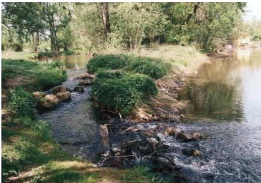
Součástí revitalizační parkové úpravy v Ambergu je rybí přechod, překonavající zdejší jez. V parku se uplatňuje jako příjemný potok
