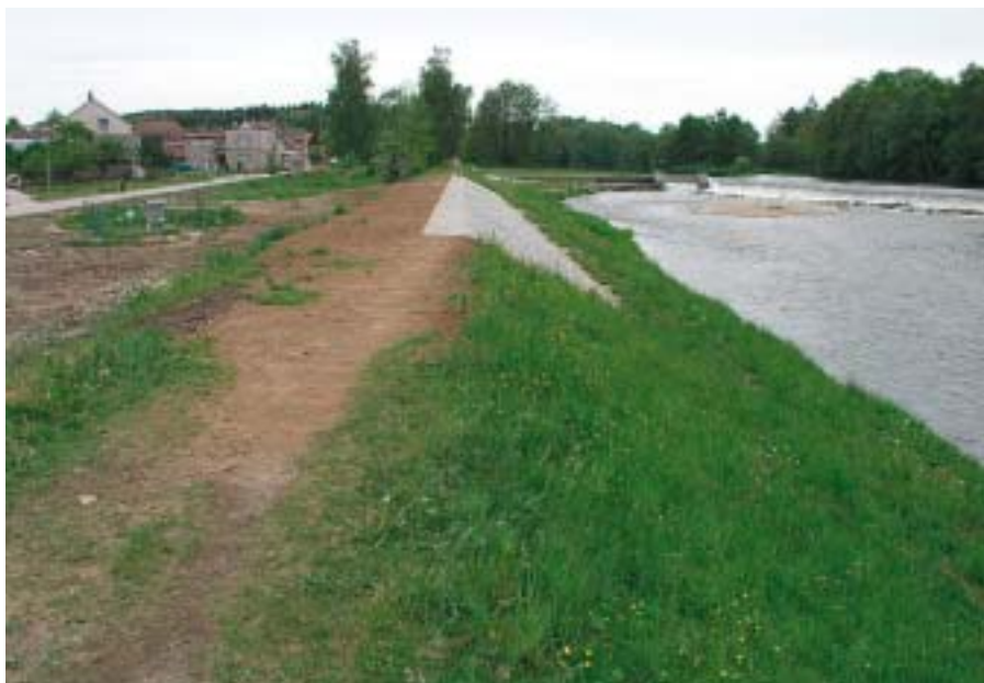
Obr. 2 – Protipovodňový val v Katovicích na Otavě.
