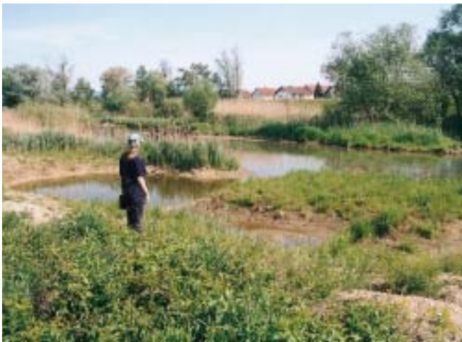
Revitalizace ohrázaného přítoku Dunaje – říčky Kössnach. V prostoru vymezeném hrázemi se rozčleňují břehy hloubením postranních tůní a mokřadních depresí
