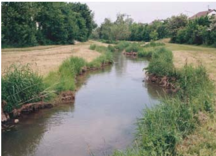
Intravilánová revitalizace říčky Aiterach v Aiterhofenu. Dříve geometricky pravidelná kyneta byla rozvolněna. Říčka se stala živou osou obce
