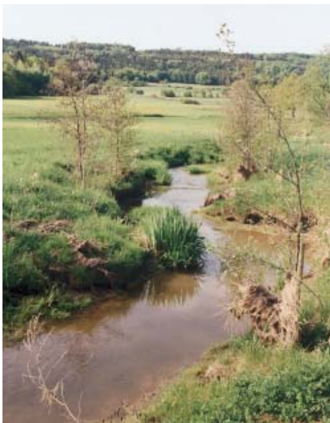
Revitalizace Ailsbachu, obec Ahorntal. Nově vytvořené koryto tři roky po dokončení nabylo přírodní charakter. Jeho důležité charakteristiky - členitost stopy, příčné a podélného profilu, zahlobení, charakter břehů - jsou již téměř srovnatelné s přírodními potoky. Na vegetaci jsou patrné stopy povodně, které koryto dobře odolalo
