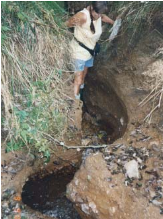
Počátek hluboké eroze lesního odvodňovacího příkopu, zřízeného ve velkém sklonu v povodí Zlatého potoka
