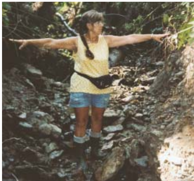
V povodí toků s biotopy perlorodky říční je nutné omezit zřizování povrchových odvodňovacích stok v lesích, které se mohou vlivem vyšších průtoků stávat silným zdrojem splavenin, které zanášají průtočné prostředí dna. Na snímku je strž vzniklá v místě odvodňovacího příkopu v povodí Zlatého potoka, která již byla Lesní správou Chroboly zavedena kamenem a pramenná stružka byla zavedena zpět do původní lesní údolnice
