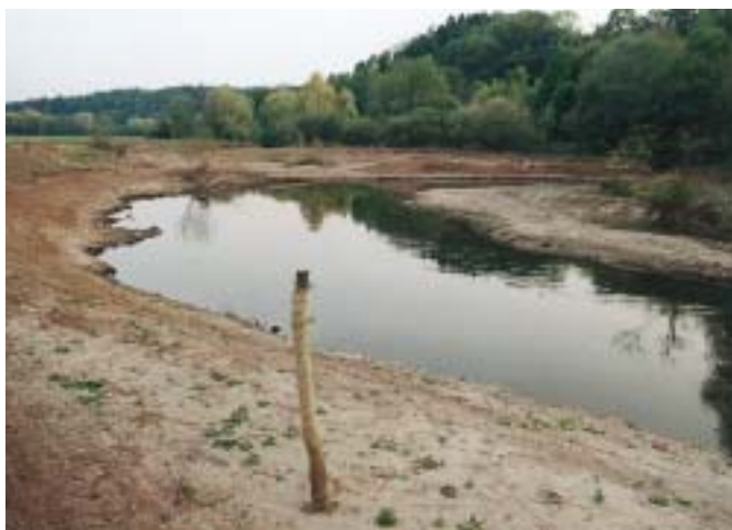
Itz u Gleusdorfu. Pro zlepšení odtoku povodňových vod byla na dříve upravené řece pod obcí obnovena soustava meandrů. Tvarování přírodní, ozelenění vrbovými kůly. (Pro ochranu je kůl omotan pytlovinou.)
