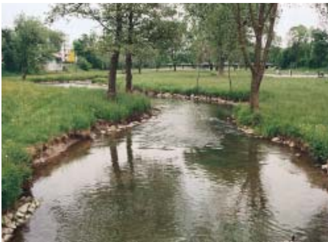
Revitalizované koryto říčky Pfettrach v ochranném povodňovém příkopu města Landshutu. Dříve mělo geometrický pravidelný tvar
