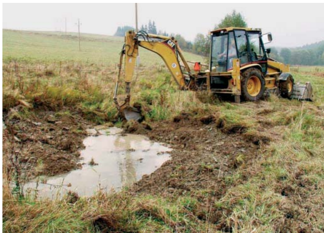
Sitka - Veverí, realizace opatření - meandrování koryta a jeho úpravy, září 2002
