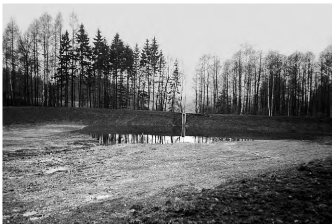
Rybník těsně po dokončení, 4/1999
