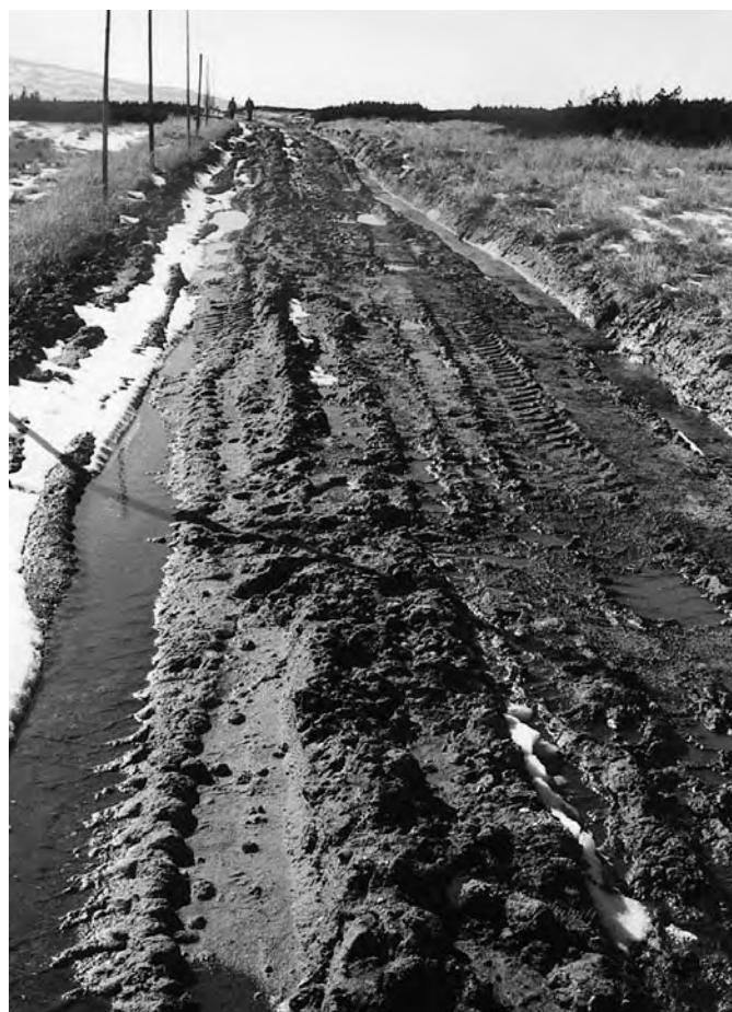
Tělo cesty po skrytí nepůvodní navážky
