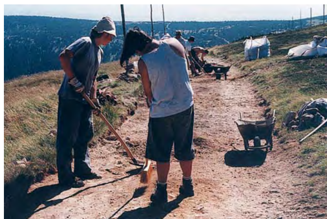
Ruční odstraňování vápencové drtě, v pozadí transportní „kabelky“
