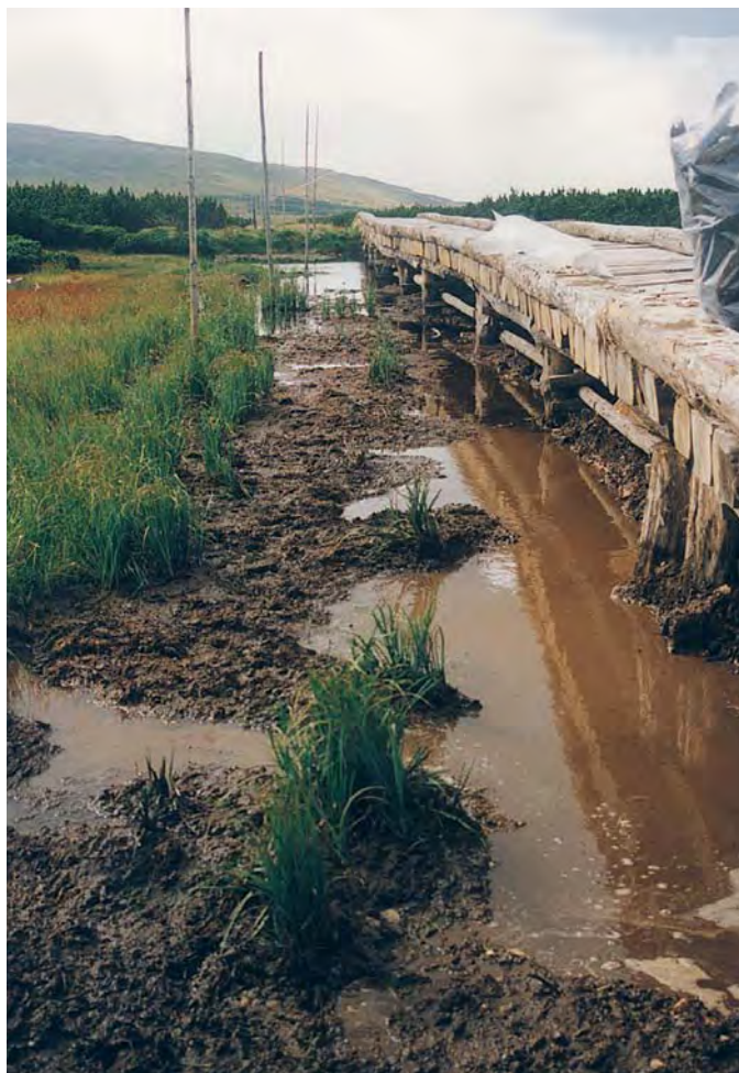
Zarůstání původně zpevněných ploch rašeliništní vegetací a pohled na dokončený chodník
