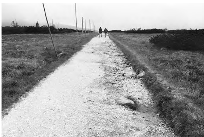
Původní stav – zpevnění cesty dolomitickým vápencem
