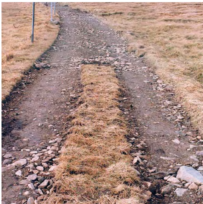
Vegetační středový pruh před navezením jemné krycí frakce
