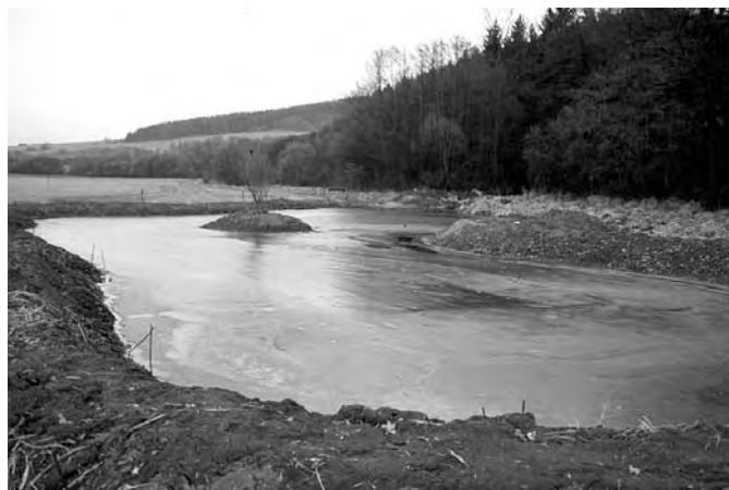
Konečný stav po provedení zemních prací – po výsadbě zeleně a zapojení travního porostu na hrázce bude lepší i nikoliv nepodstatný estetický dojem
