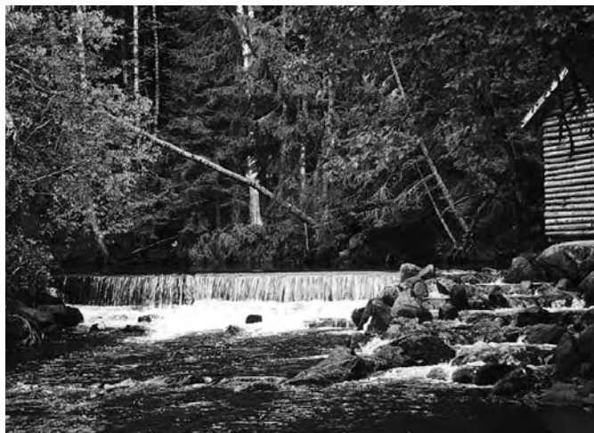
Přírodě blízké rybí přechody umožňují migrace ryb i dalších vodních živočichů včetně bezobratlých (rybí přechod Zahrádky II na Teplé Vltavě v NP Šumava)
