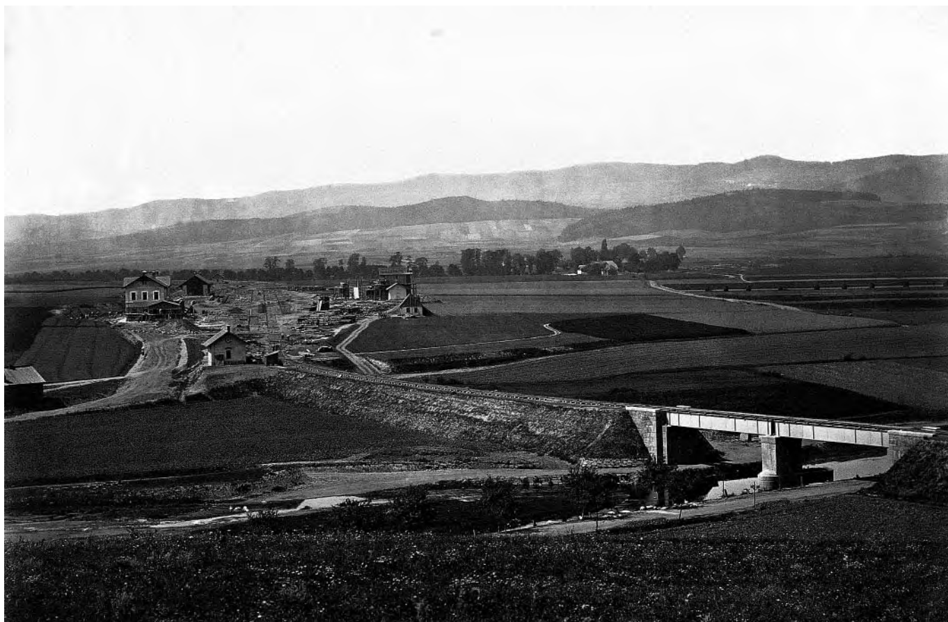
Stavba železnice Plzeň – Železná Ruda, 1875
