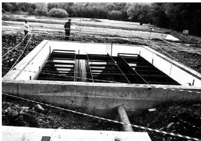
Výstavba větší vegetační čistírny, podpořená Programem drobných vodo hospodářských ekologických akcí, v Obecnici u Příbrami. Šterbinová usazovací nádrž (v popředí) je velmi významná pro spolehlivý provoz čistírny
