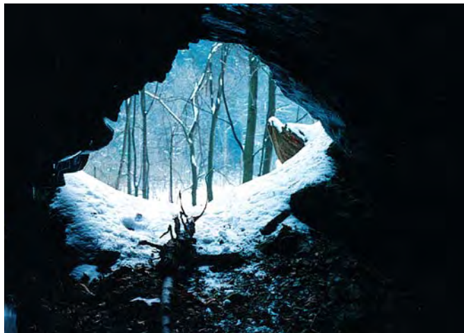
Ústí štoly před zabezpečením
