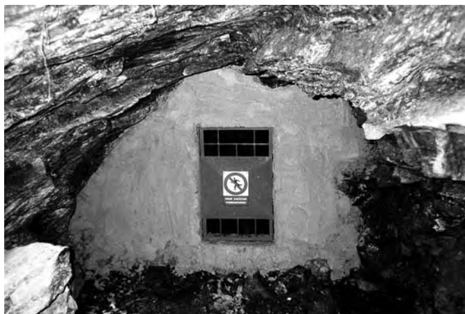
Ústí štoly zabezpečené mříží
