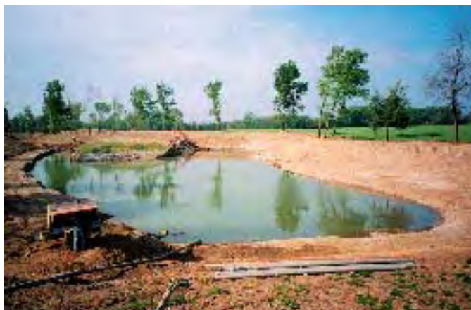
Budování trvalé vodní plochy s ostrůvkem v rámci revitalizace odstaveného meandru
