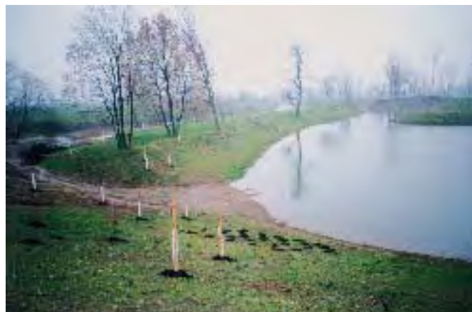
Obnažené plochy byly zatravněny a osázeny dřevinami vhodného druhového složení
