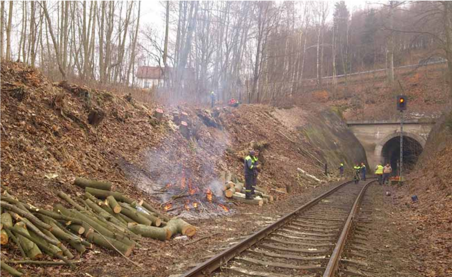
Kácení dřevin v obvodu dráhy na Liberecku v rámci „údržby“ železniční tratě. Foto: archiv Magistrát města Jablonec nad Nisou
