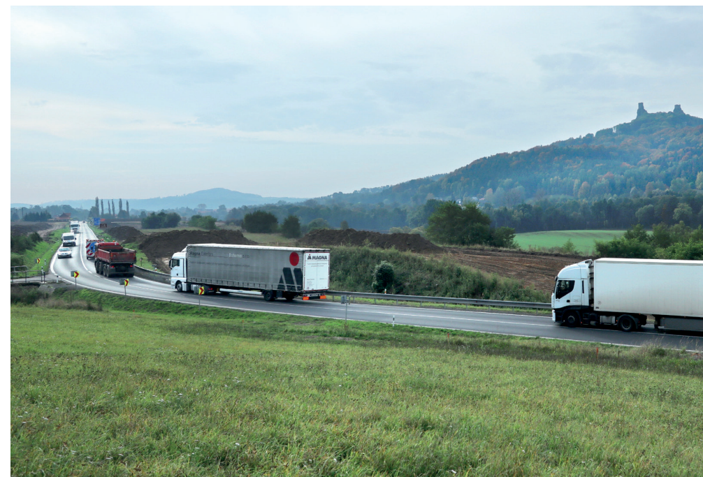
Ilustrační foto. Přestavba silnice E442 pod Troskami v Českém ráji. Foto archiv AOPK ČR
