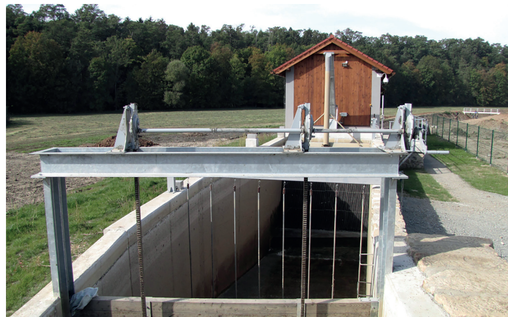
Diody elektronické zábrany a jemné česle. Foto archiv AOPK ČR
