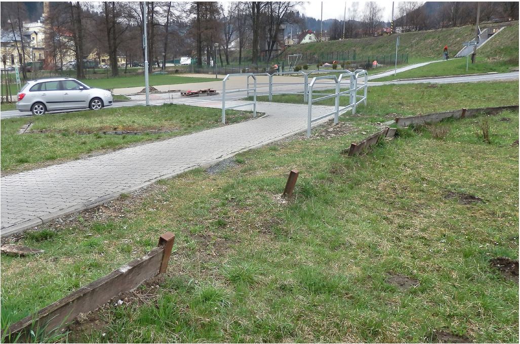
V Hanušovicích vybudované dřevěné zábrany nefungují, řada dřevěných polí chybí, a žáby tudíž nejsou naváděny do podchodu, ale dostanou se přímo na silnici. Foto Antonín Krása
